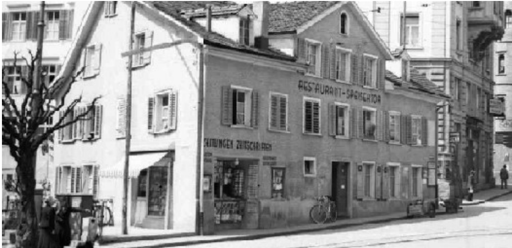
Ehem. Rest. Spisertor, Burggraben 2, 9000 St. Gallen (1950)
